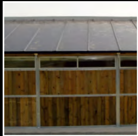
- Toit isolant avec panneaux sandwich 50 mm -
